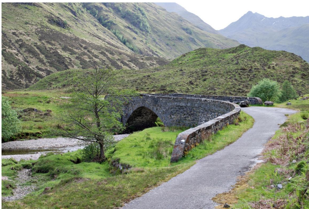
Vista lateral del puente
